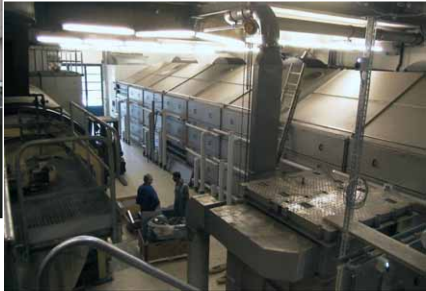
Die fertig gestellte erste Trocknungsstrasse
