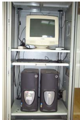
Umbauphase 1 Ersatz des kompletten Leitsystems und Erstellung der neuen Software
